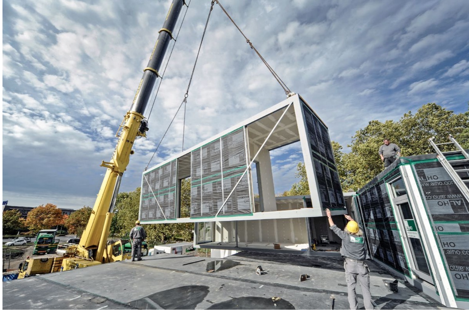
Die Bauarbeiten gehen voran.
