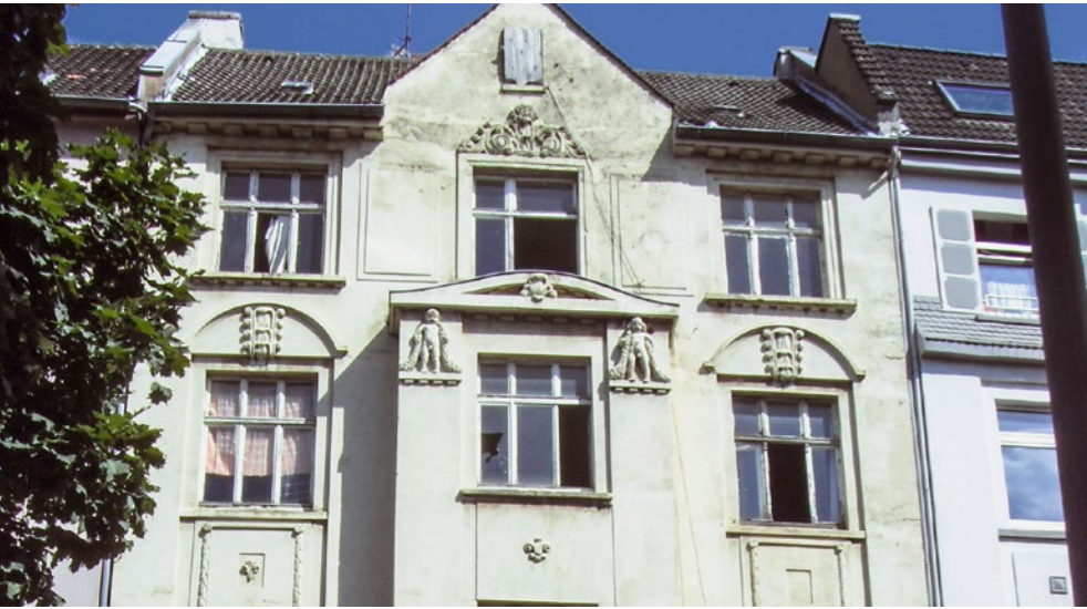
Die Außenfassade des Wohnhauses Brunnenstraße 51 vor der Sanierung ...
