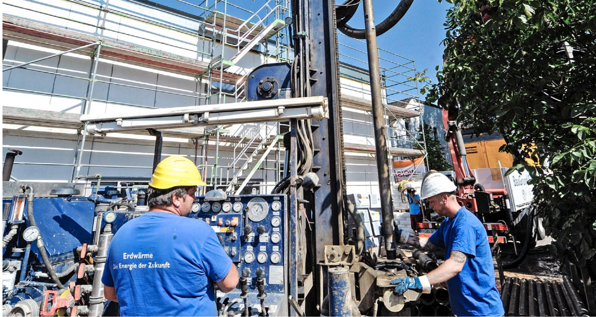
Bohrarbeiten für die Sole-Wasser-Wärmepumpe der Kindertagesstätte Weingartenstraße
