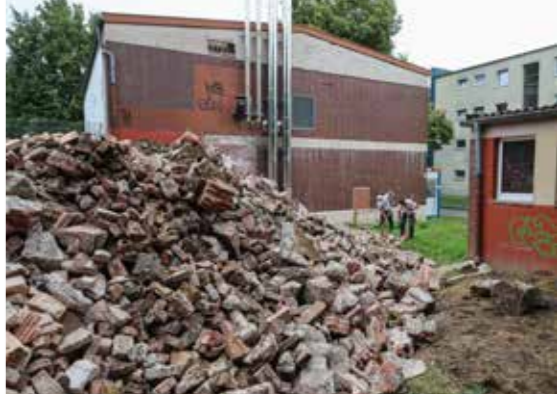
Ein Haufen Steine als Überbleibsel: Anfangs wurde der Kamin per Hand bearbeitet, bevor der Bagger zum Einsatz kam.
