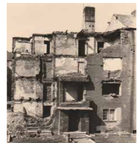
Kriegsschäden an der Reichswehrstraße vor dem Wiederaufbau.
